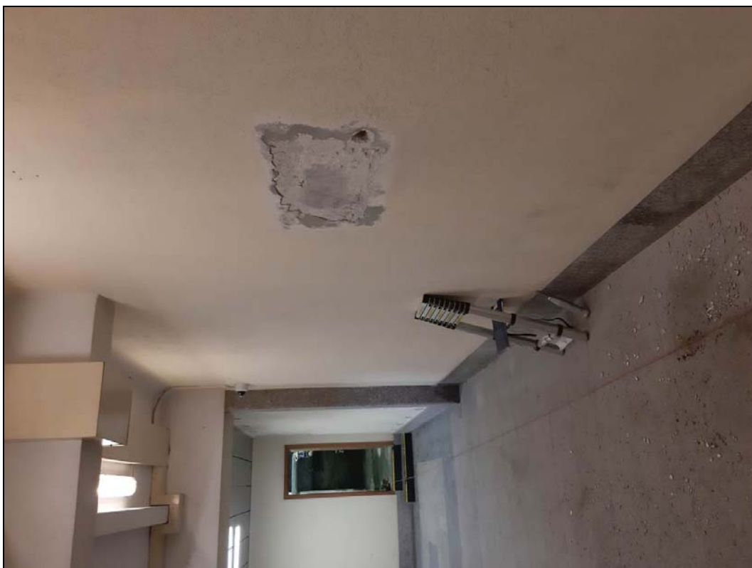
Obr. č. 6 - ZM 2 - opěra trámu na vnější zdi chodby, která je z prostého betonu.
