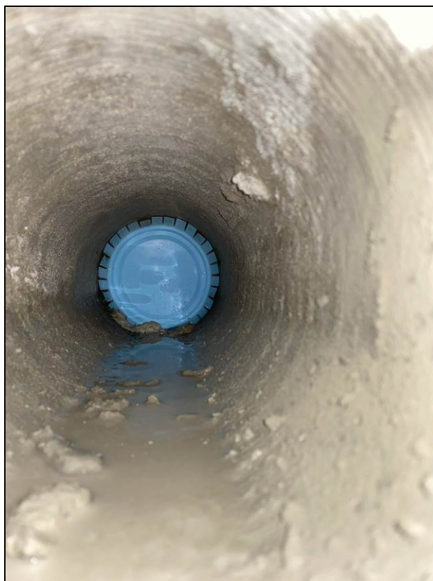
Obr. č. 21 - pohled do dutiny stropního panelu Spiroll (foceno z vrtu S1)
