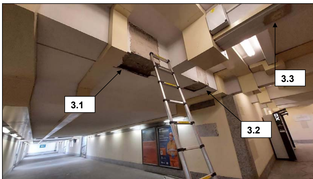
Obr. č. 8 - ZM 3 - celkový pohled na soustavu stropních trámů, překladů, které jsou v půdoryse uspořádány do tvaru písmene L. Zde bylo provedeno ověření stavu v rámci 3 dílčích lokalit - viz popisky.
