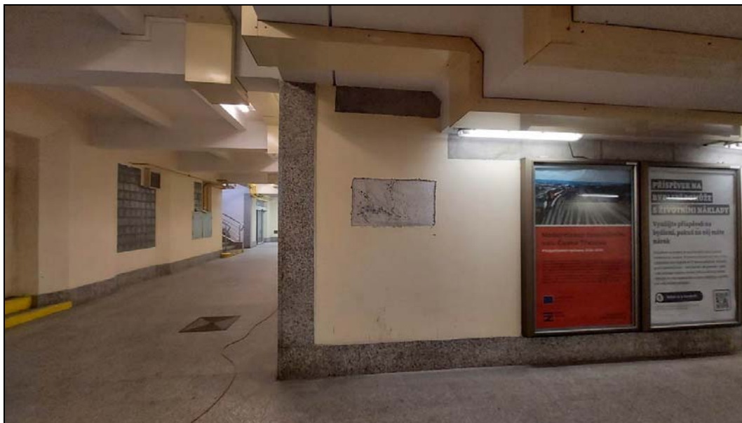
Obr. č. 9 - ZM 3 - pohled na opěru trámu pod lokalitou 3.1. Opěra je z prostého betonu. Stejná situace je na protější straně podchodu
