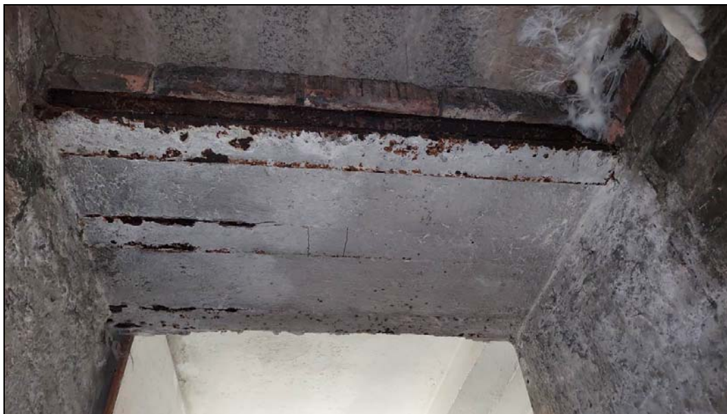
Obr. č. 3 - ZM 1 - opěra překladu nad otvorem z cihlového zdiva. Detailní pohled, konstrukci tvoří 3 kolejnice, které jsou přiznané ve spodním líci a bocích konstrukce.
