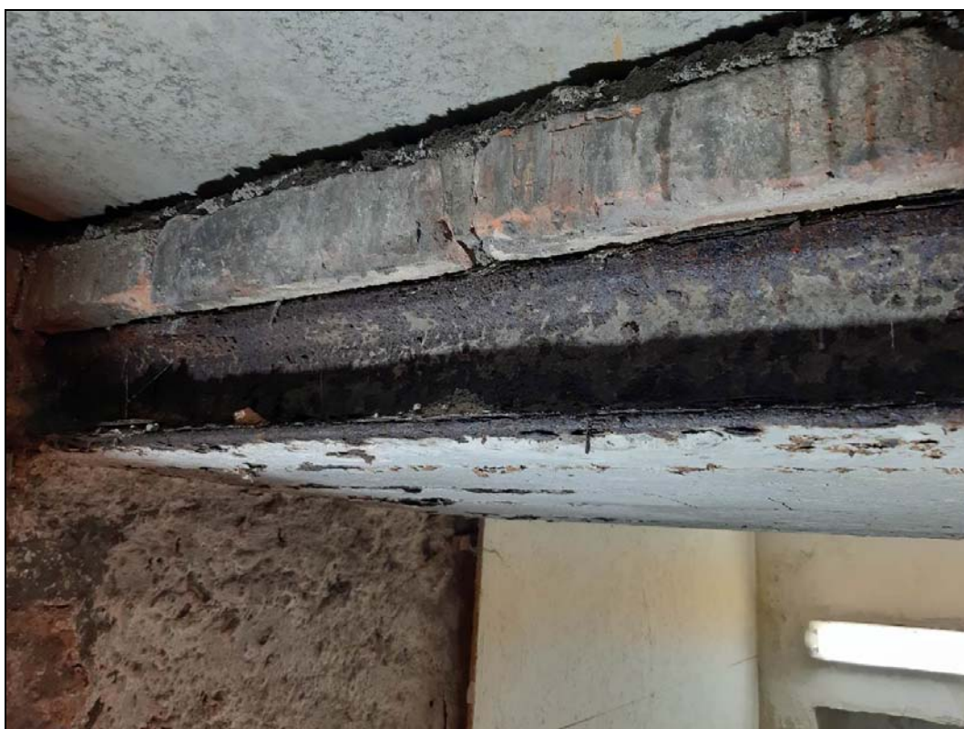
Obr. č. 4 - ZM 1 - detailní pohled na bok kolejnic v překladu. Kolejnice jsou celoplošně postiženy povrchovou korozí, která přechází na vnějších hranách do koroze hloubkové s tvorbou korozních splodin.
