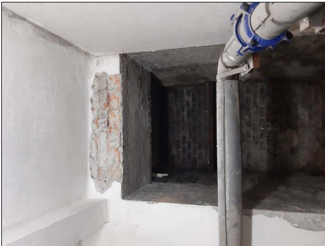
Obr. č. 1 - ZM 1 - překlad nad průchozím otvorem ve zdi. Konstrukce je z ocelových nosníků kolejnic obezděných cihlovým zdivem
