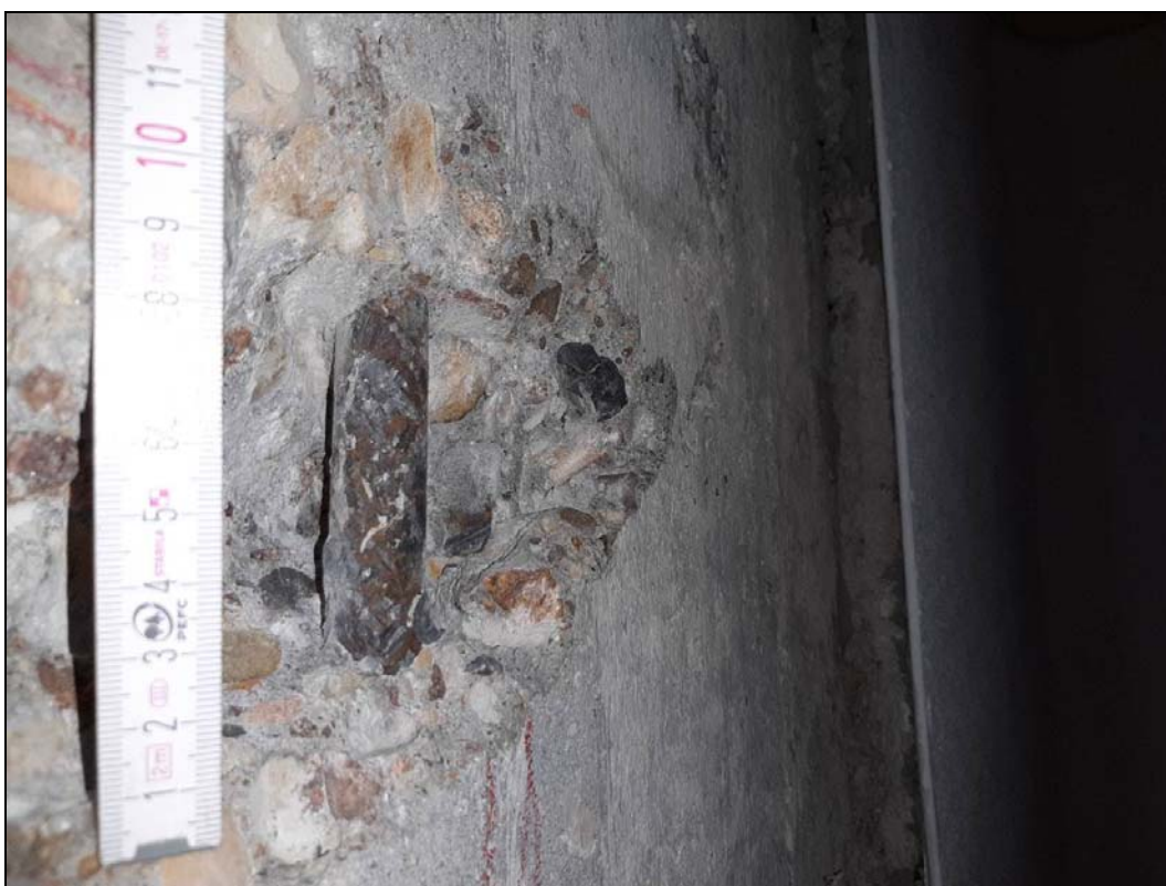
Obr. č. 12 - ZM 3 - detailní pohled na spodní líc trámu s odhalenou výztuží na 3.2
