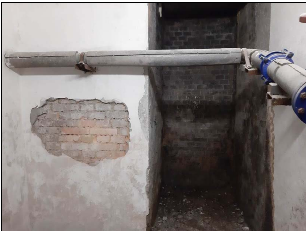
Obr. č. 2 - ZM 1 - opěra překladu nad otvorem z cihlového zdiva. Na fotografii je patrná zvýšená vlhkost prostoru, zdiva a degradace omítek.
