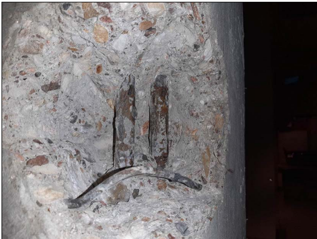
Obr. č. 7 - ZM 2 - detailní pohled do destruktivní sondy ve spodním líci trámu pro odkrytí hlavní nosné výztuže. Beton je pevný, kompaktní. Výztuž je s povrchovou korozí, nesymetricky uložená v rámci prvku.
