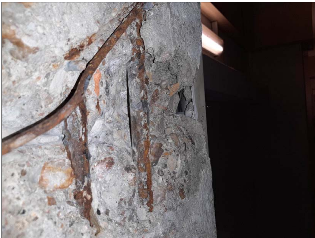
Obr. č. 13 - ZM 3 - detailní pohled na spodní líc trámu s odhalenou výztuží na 3.3
