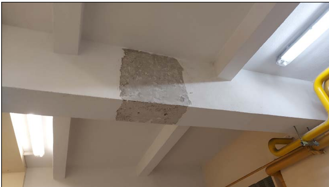
Obr. č. 5 - ZM 2 - stropní trám, resp. překlad v chodbě v suterénu. Trám je z vyztuženého betonu. Ověřované místo bylo v \frac{1}{2} rozpětí.
