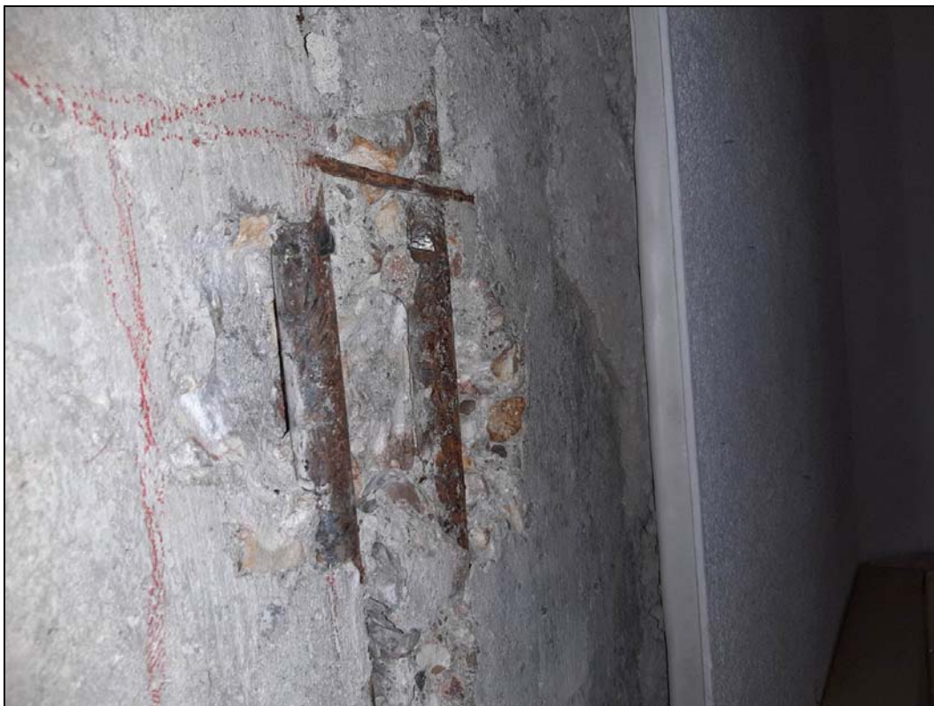
Obr. č. 11 - ZM 3 - detailní pohled na spodní líc trámu s odhalenou výztuží na 3.1
