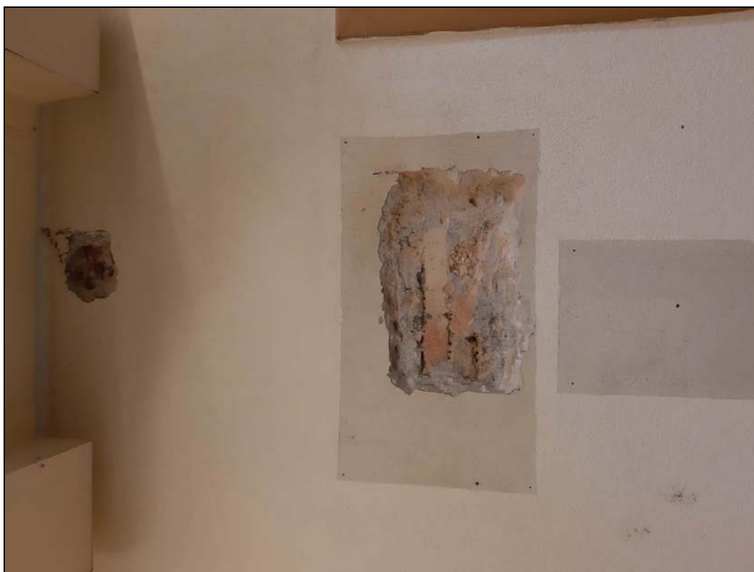
Obr. č. 15 - ZM 4 - detailní pohled na sondy do líce zdi, ve kterých je patrné cihlové zdivo.
